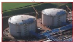
1 Dragon LNG Milford Haven, UK.
